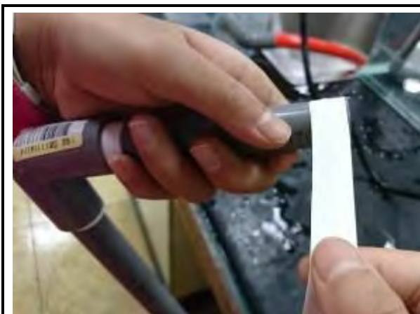
水管連接的地方纏上止洩帶，防止漏水。
