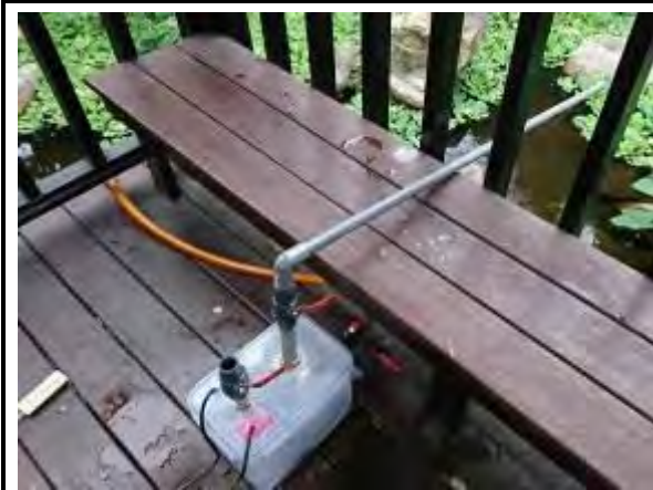
用更長的水管把吸水口延長到水池裡。
