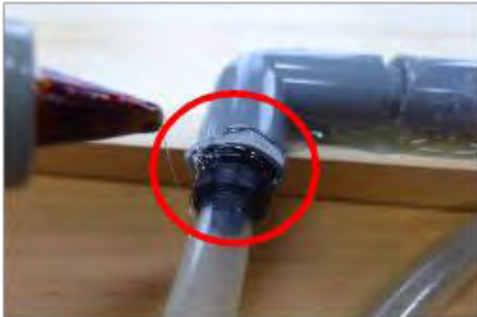
透明水管纏上膠袋塞入水管
