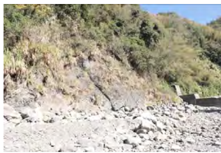
圖 1-35: 特富野大橋橋下東邊河床的防砂潛壩。
