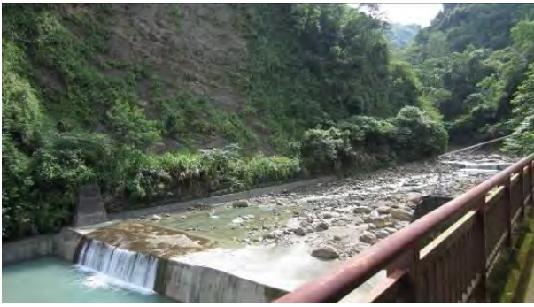
圖 6-1、圖 6-2:腦寮溪和八掌溪防砂壩工程，圖中是潛壩工程，溢水口還加上了鐵片保護。
