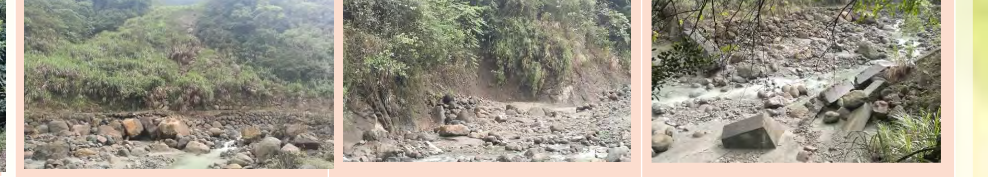
位於腦寮溪大崩塌地河岸的蛇籠護岸 腦寮溪河岸的侵蝕凹岸，砂岩凸頁岩凹 腦寮溪上，被河水侵蝕沖垮的防砂壩
