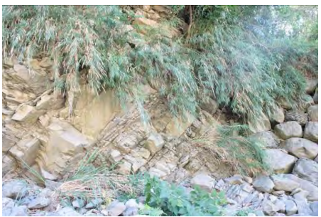
圖 1-34: 特富野大橋橋墩附近砂岩和大型砌石牆。
