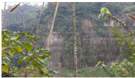
圖 2-22: 河道南邊砂頁岩互層崩塌面接近垂直。
