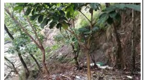
圖 2-3: 天長吊橋南端的的層風化成土壤。
