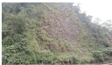
圖 2-1: 薄層砂頁岩互層的露頭，坡型屬逆向坡。
