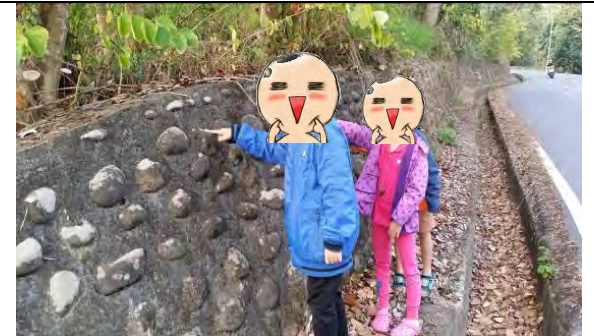
圖 6-8:漿砌卵石擋土牆與排水溝設施
