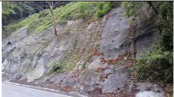
圖 6-3:台 18 線 36K 崩塌坡面用噴水泥漿覆蓋
