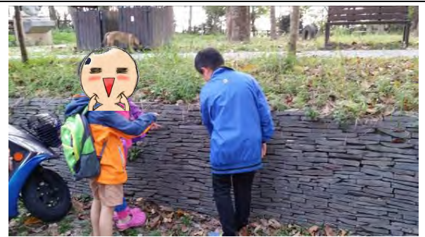
圖 6-7:蘭潭泛月園區附近用板岩砌成擋土牆
