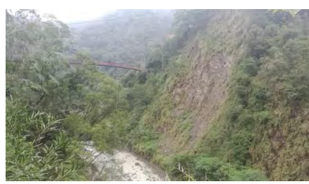
圖 2-2: 天長吊橋的北端，坡面很陡的傾斜露頭。
