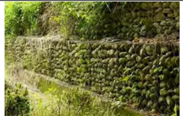
圖 6-5:用鐵絲網編造裝鵝卵石的蛇籠擋土牆
