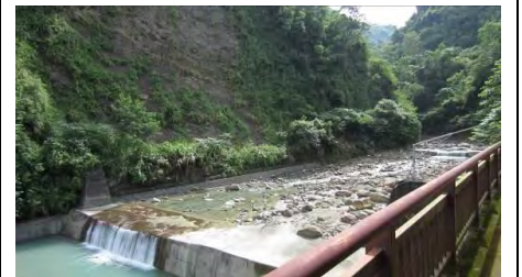
圖 2-6: 天長吊橋下是腦寮溪，有三段的潛壩。
