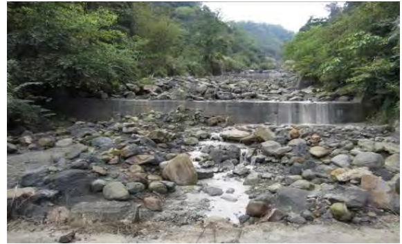
圖 6-1、圖 6-2:腦寮溪和八掌溪防砂壩工程，圖中是潛壩工程，溢水口還加上了鐵片保護。
