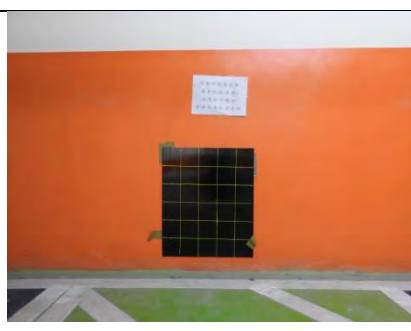
圖：4-25 A 棟地下室
