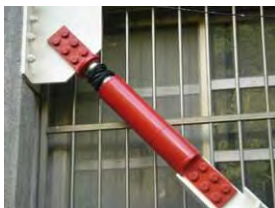
圖 1-7 斜撐消能阻尼器
