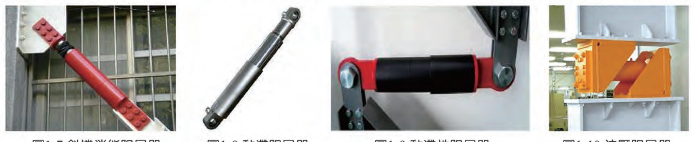
圖 1-7 斜撐消能阻尼器
