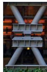
圖 1-5 位移型制震阻尼器
