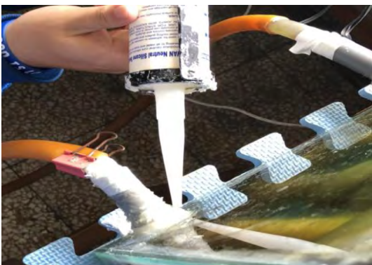
圖 12.改善進排水管漏水
