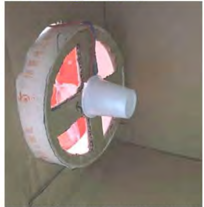
出口排風扇的馬達以小塑膠杯覆蓋 避免酸氣腐蝕馬達金屬部份
