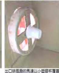
出口排風扇的馬達以小塑膠杯覆蓋避免酸氣腐蝕馬達金屬部份
