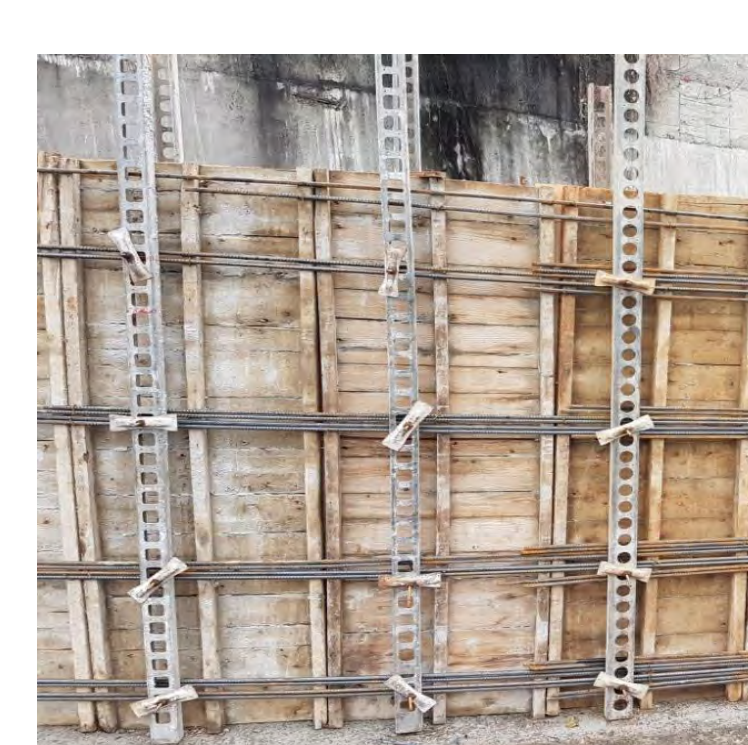
圖 20 擋土牆施工
