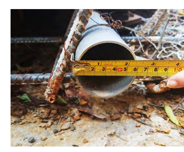
圖 25 丈量排水管口徑
