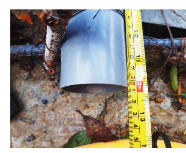
圖 24 丈量排水管長度
