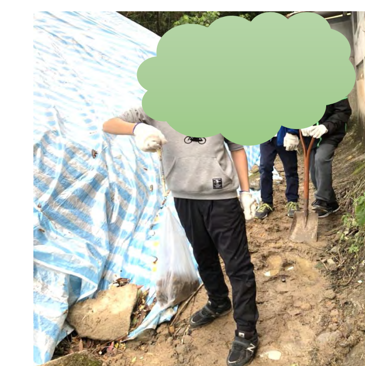
圖 19 景華街崩塌處採集土樣
