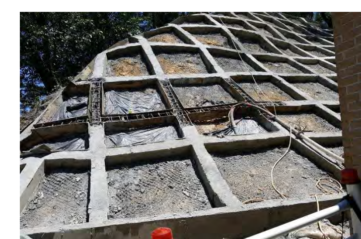
圖 22 修復工法：網格護坡
