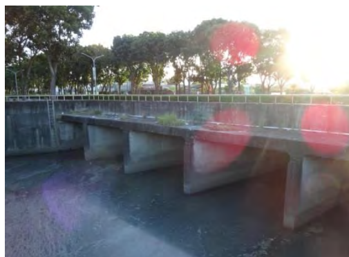
a.位於本市世賢路之下水道集水區
