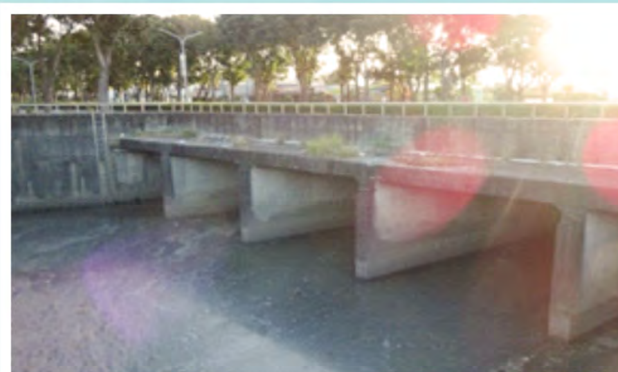
a.位於本市世賢路之下水道集水區
