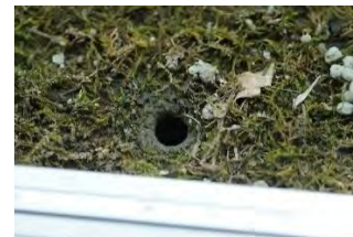
測量隧道口的孔徑
