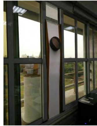
▲圖 22：象鼻風管裝置於窗台
