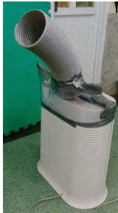
▲圖 21：象鼻風管完成圖
