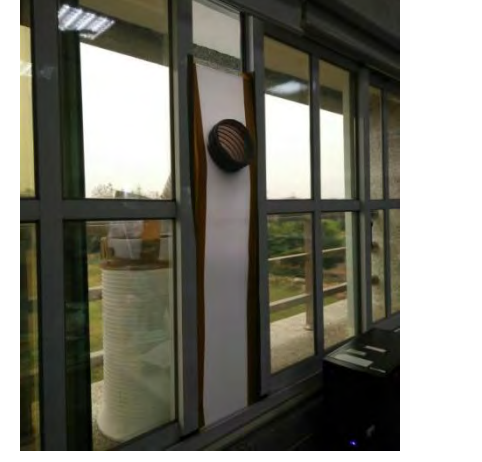
▲圖22：象鼻風管裝置於窗台
