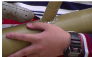
用熱熔膠固定接風管
