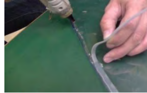
3. 將軟塑膠墊黏在收球管前端，並確認收球管與收集器主體密合
