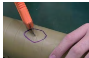
在接延長管的一端距離 30cm 處割出一個直徑 3cm 的圓洞
