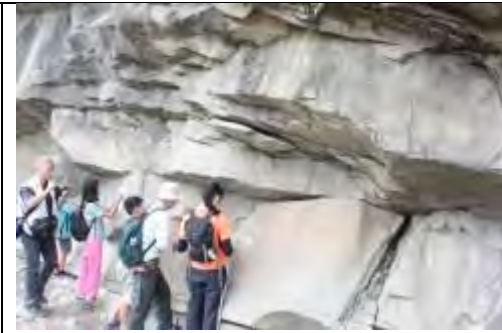
巨大的砂岩南北向大約 150 公尺，高度大約 60 公尺，我們正在測量巨大的層面。
