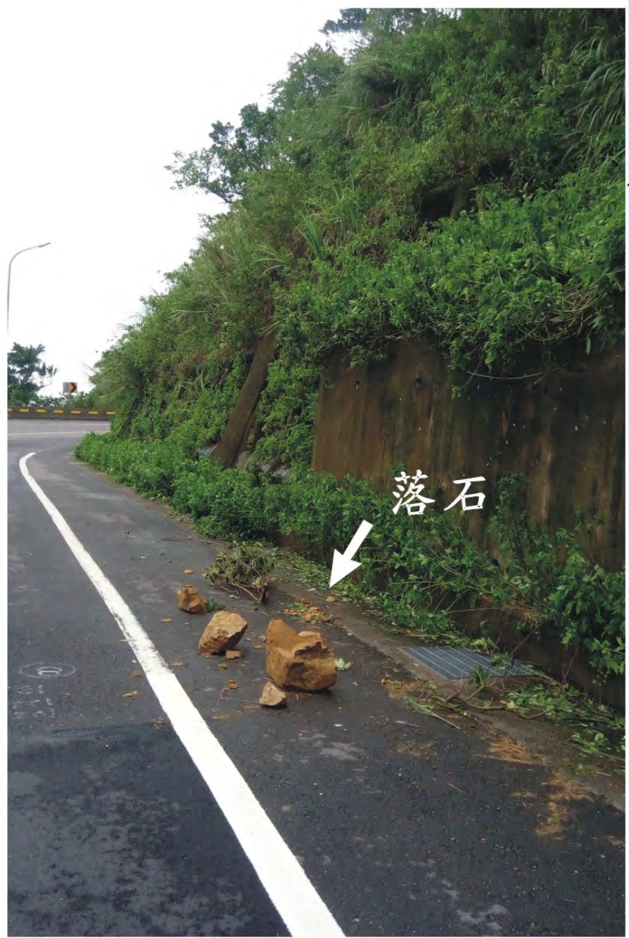
圖五(d)梳榔腳因豪大雨，產生落石
