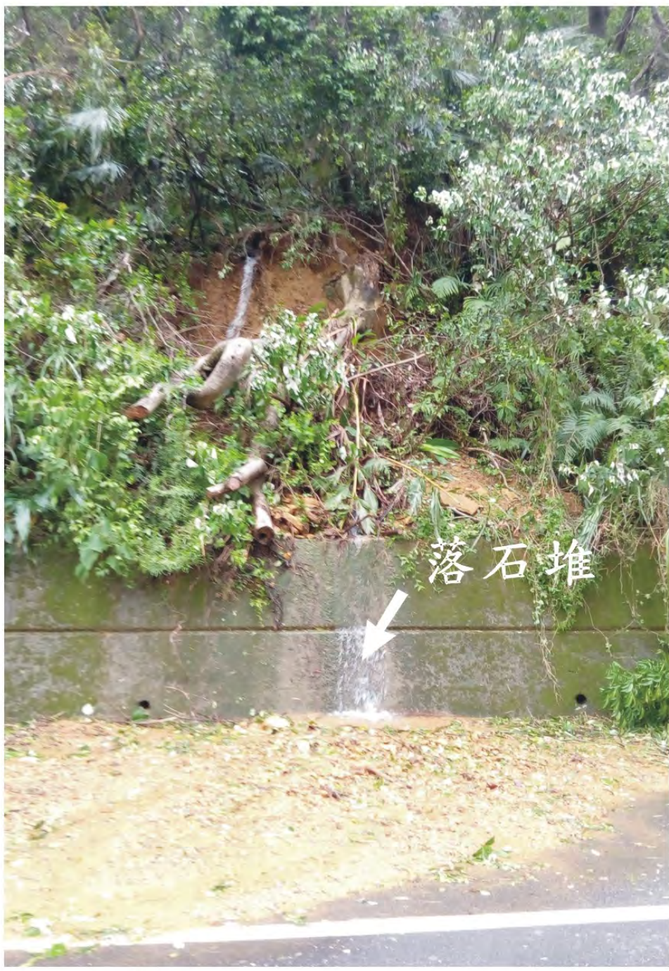
圖五(c)七番坑因豪大雨，發生落石堆
