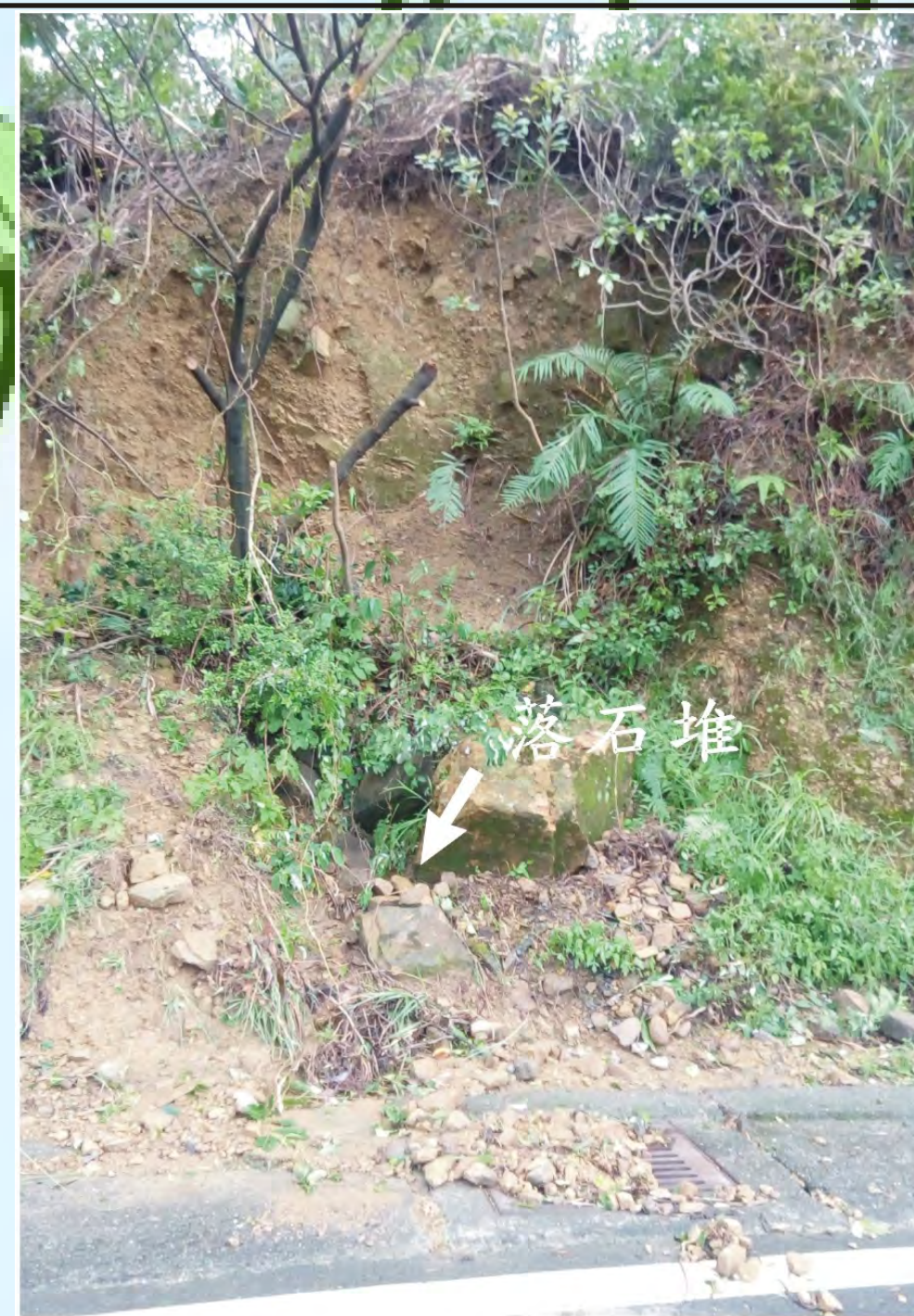
圖五(a)瑞金路因豪大雨，發生落石堆
