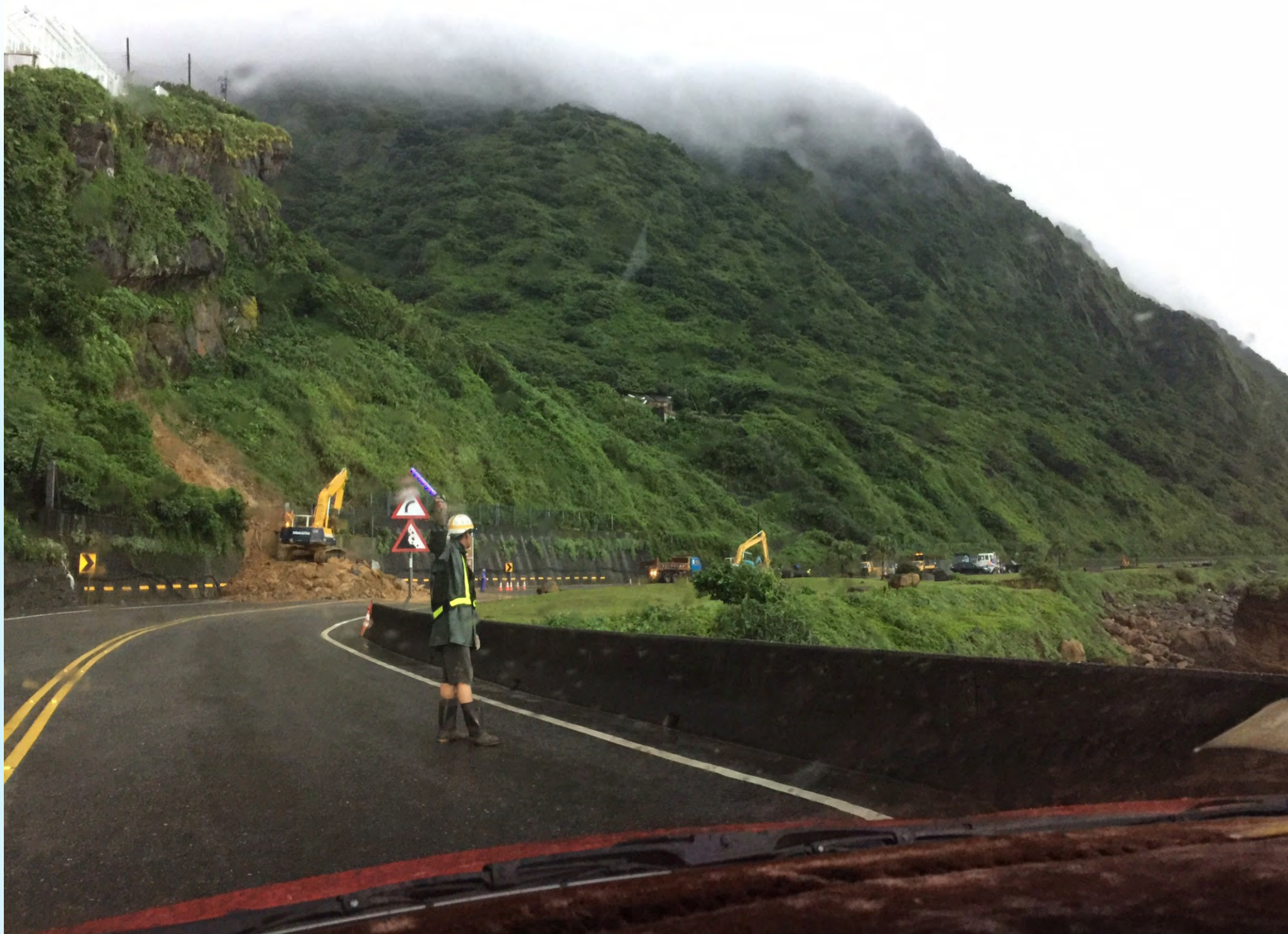
(2號省道水滴洞附近，雨量超過240mm以上發生山崩)
