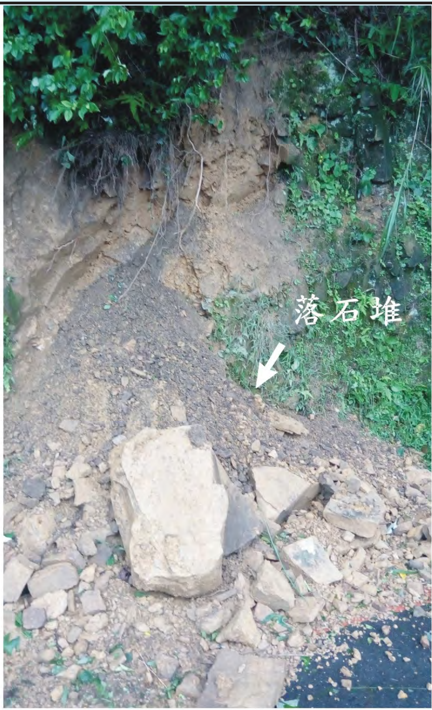
圖五(b)五番坑因豪大雨，發生落石堆
