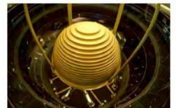
圖2. 臺北101大樓風阻尼器(TMD)特寫近照
