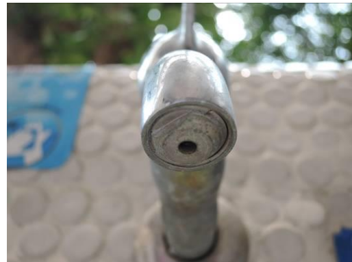
圖 15:第二種省水器構造
