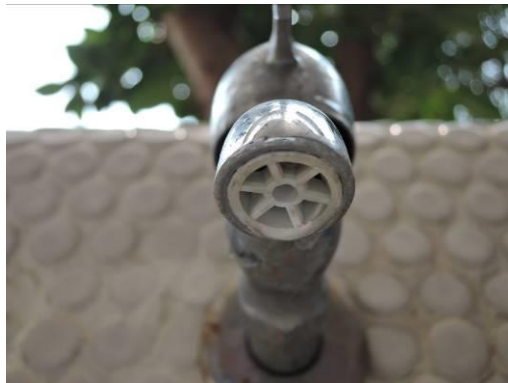
圖 14:第一種省水器構造
