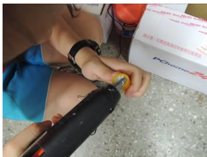
圖 6:用熱熔膠固定瓶蓋在水管上
