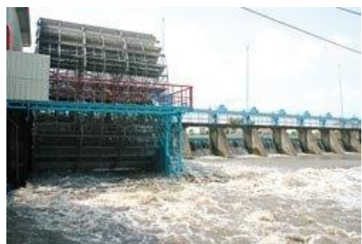
川流式水力發電機
