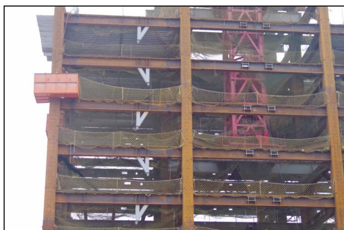
圖 1-3 建築物的工字樑與口型柱
