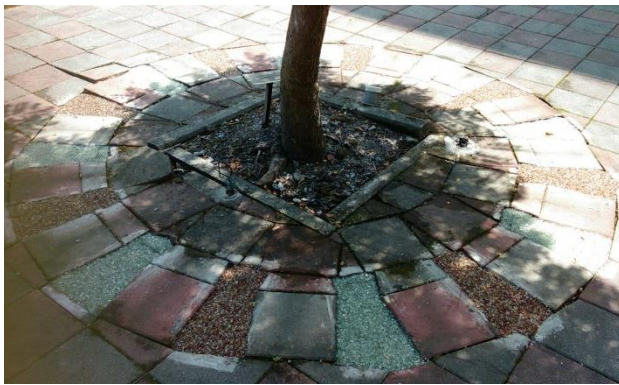
圖 16 碎玻璃透水磚-現場實測 2
