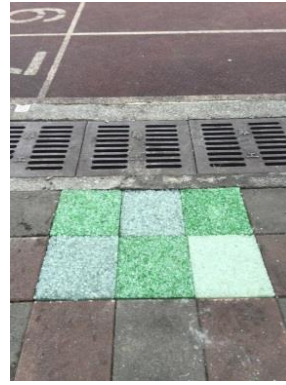
圖 15 碎玻璃透水磚-現場實測 1
