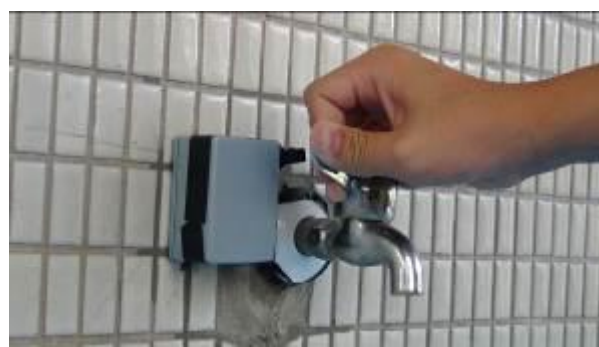
圖8 紅外線感測器安裝
