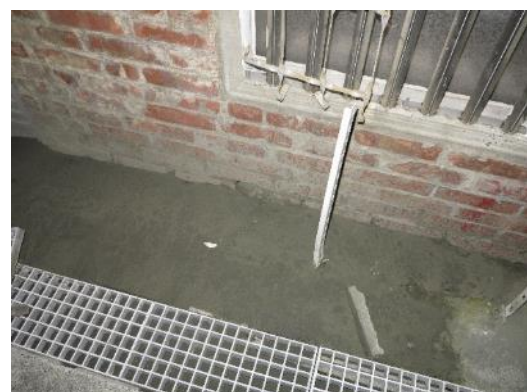
照片 20 中西區文和街道路兩側房屋下陷傾斜，多處牆角出現噴砂。
