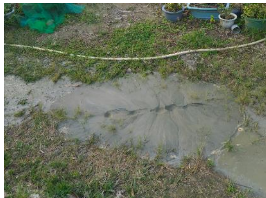
照片 44 保吉路 175 巷 33 號後庭院的一處裂縫與噴砂。
