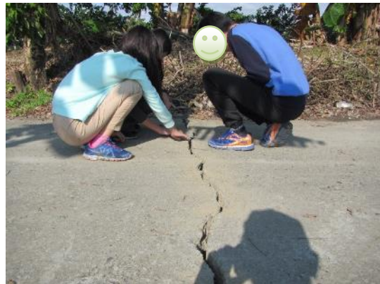
照片 4 液化點附近路面因地震發生斷裂。
