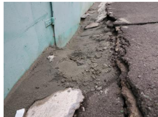
照片 18 新市區三民街 50 巷 10 弄透天厝土壤液化噴砂房屋下陷傾斜。
