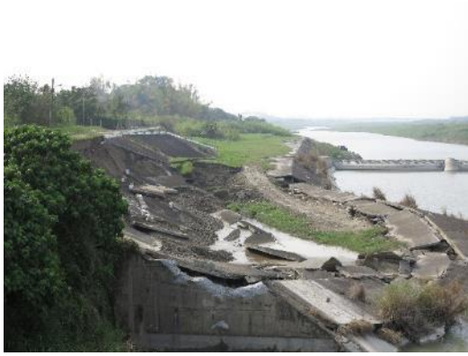
照片 15 山上區山上淨水廠後方玉峰堰因土壤液化也發生側崩現象。
