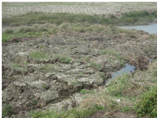
照片 13 官田區日新護岸土石因土壤液化發生側崩現象。
