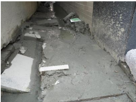
照片 17 安南區府安路四段 176 巷新建透天厝土壤液化房屋傾斜。
