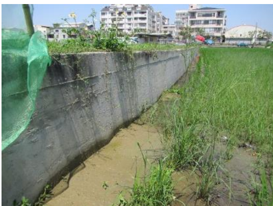
照片 45 大灣東路南側填土的農田與原來稻田高度相差約 1.5m。
