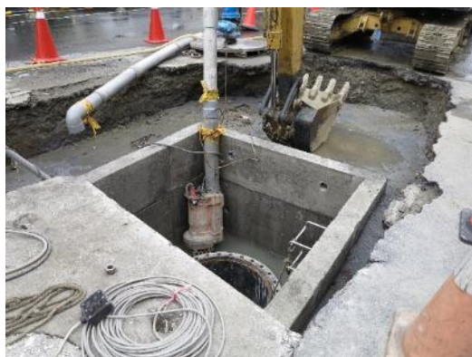
照片 21 安南區長和路三段土壤液化造成大自來水管自來管脫落漏水。
