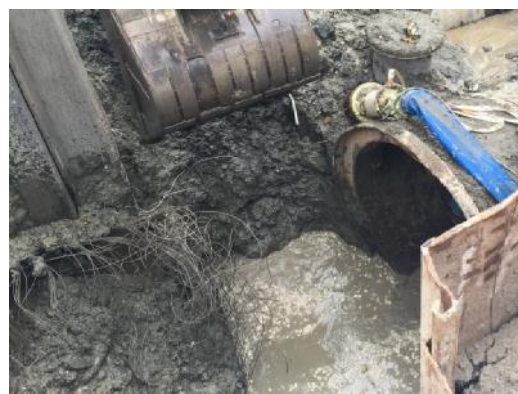
照片 22 永康區有多處地下水管疑似土壤液化造成破損。
