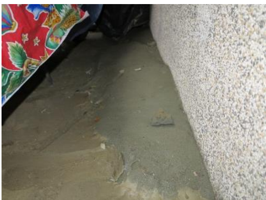
照片 19 北區正覺街 102 巷 40 弄房屋下陷傾斜，牆角出現噴砂。
