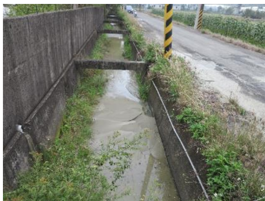
照片 39 北勢里 133 號前水溝噴砂與路面噴砂相距約 1.5m。
