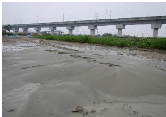
照片 6 民國 105 年 0206 地震北勢里 高鐵東側土壤液化。
