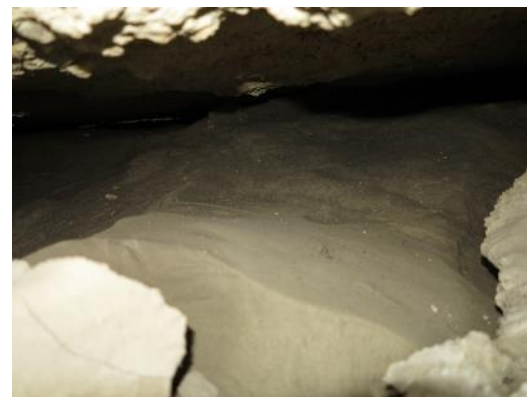
照片 14 大內區二溪大橋尖山堤防破裂水泥內的液化噴砂。
