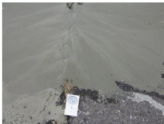
照片 40 路面青灰色砂的噴發深度約 5m+1.5m=6.5m 。
