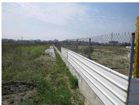
照片 41 新化外環道南側一處填土農田，圍牆內外的噴砂相距約 1m。
