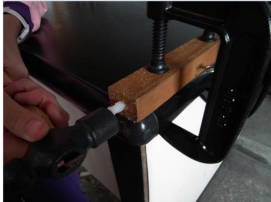
圖七 將塑料膨脹管打入木條中
