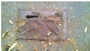
圖1 水溝蓋紗網破損
