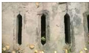
圖2 R.C 水溝蓋紗網脫落
