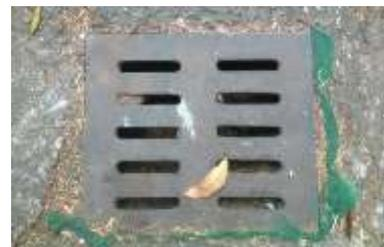
圖6 十孔水溝蓋阻塞
