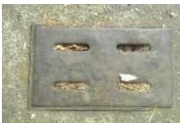
圖4 四孔水溝蓋紗網阻塞
