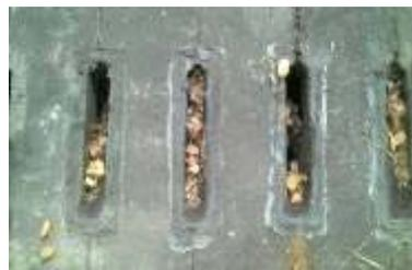
圖5 R.C 水溝蓋紗網阻塞
