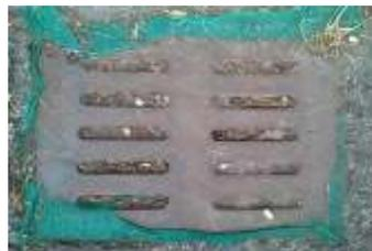
圖 35 水溝網堵塞
