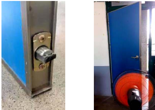
圖 15 門擋裝置實體裝設與操作
