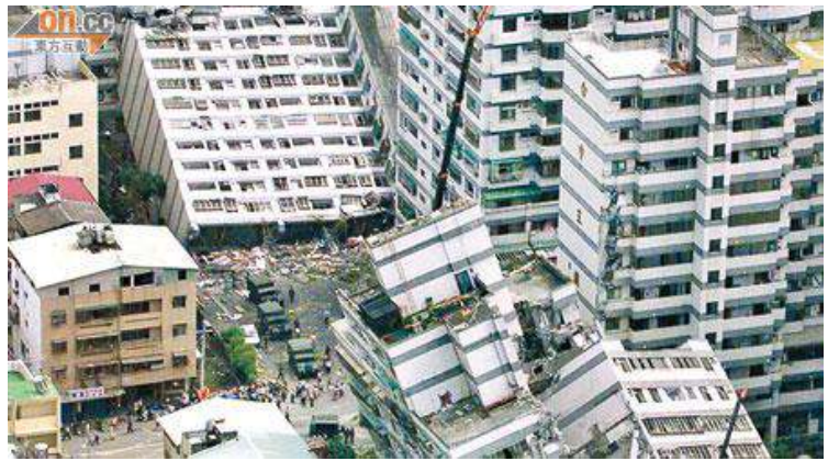
圖 1-2 房舍倒塌時發生連鎖效應
