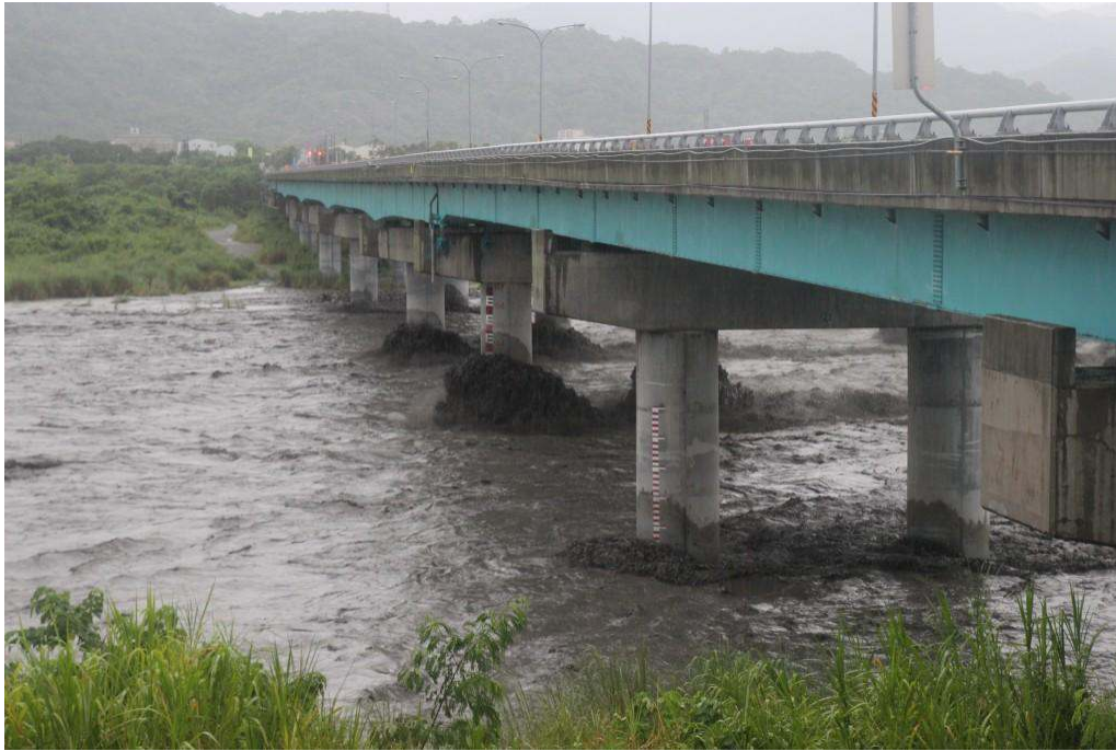
濁水溪名竹大橋於麥德母颱風(2014年7月)期間所拍攝到的橋墩周圍洪水過程
