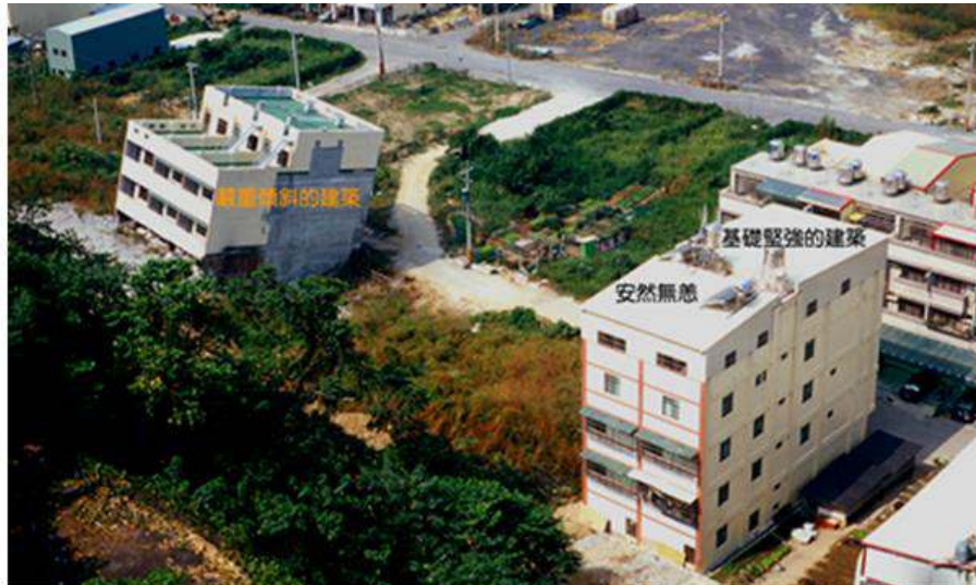
圖二十八 921地震之時，與車籠埔斷層交會的房屋幾乎全被震倒或被震歪斜，途中一棟樓房，因為基礎特別堅固而安然無恙(洪如江攝於豐原市中正公園)
