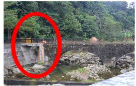
圖 1、受損修復後的清水橋
