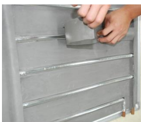
圖 50 加裝隔熱材質
