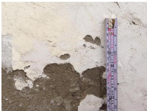
圖2 海砂屋混凝土牆
