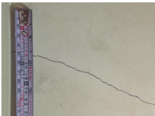
圖 3 小裂縫混凝土牆
