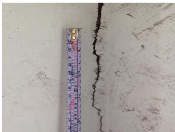
圖 4 大裂縫混凝土牆
