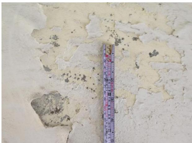
圖1 壁癌混凝土牆
