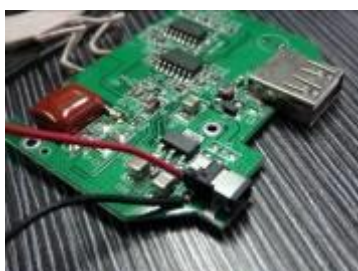
圖 22 拉出供電端與電錶串接
