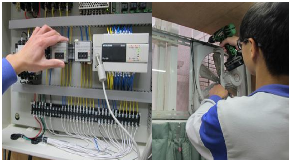
圖 4-9 PT100 配線製作與排風扇裝置
