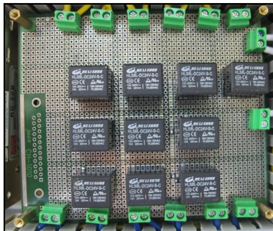
圖 5-1 本小組所焊製的隔離裝置
