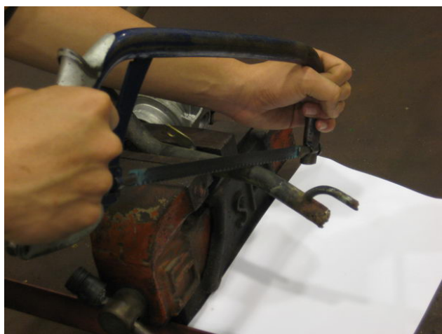
圖 7 金屬熱水管裁切
