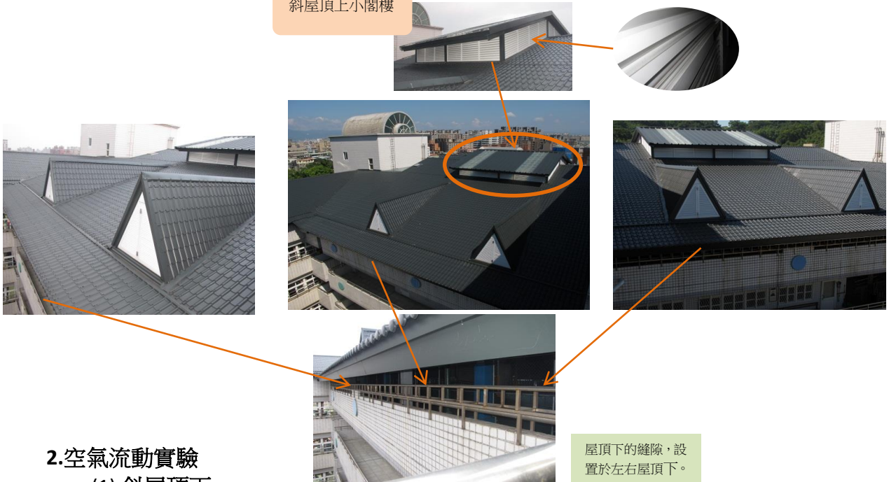
斜屋頂上小閣樓
