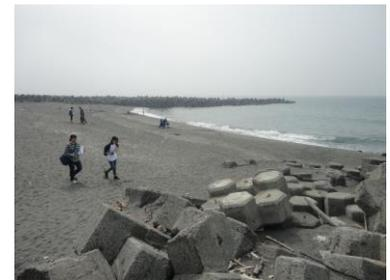
3. 風車公園：在海岸外的離岸堤工程已完工，從遠處看去會看見露出海面一小塊消波塊，去年初見到裸露的石頭地基已不復見，原本鐵片內的石頭，現在都已經變成了沙灘。
