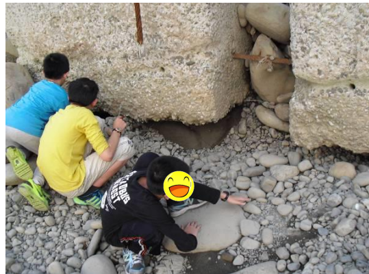
觀察舊的方形鼎塊下方侵蝕狀況
