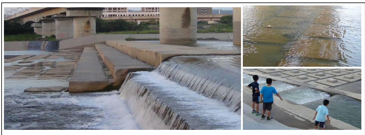
圖十二：高鐵橋下的取水堰構造
