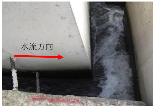
新設的方形鼎塊間正對下一塊處水流特別湍急
