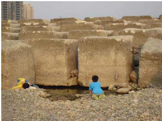
觀察舊的方形鼎塊下方侵蝕狀況
