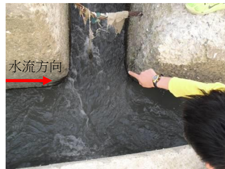
舊的方形鼎塊基部轉角處被侵蝕而凹入
