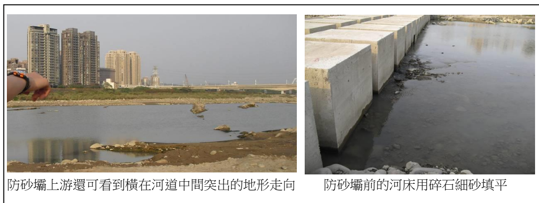
圖四十四：防砂壩修復後的河床
