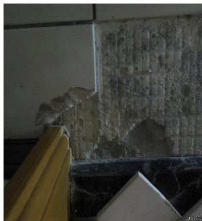
圖 1-2 磁磚破裂現象
