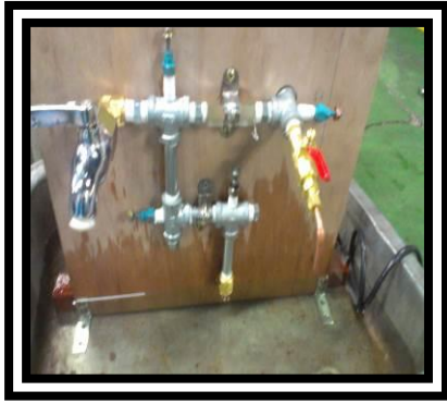
圖10. 預熱塞和水管組裝完成
