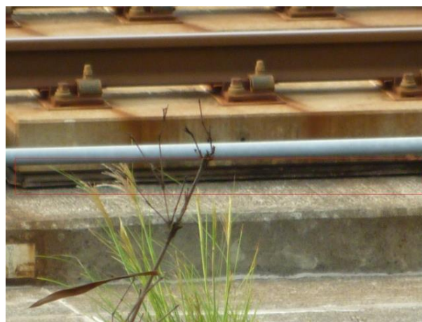
圖二十八、鐵軌下方墊片
