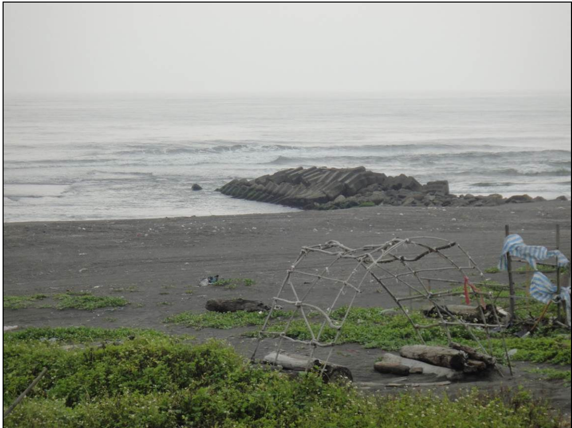
圖十九 得子口溪口北岸堤防（攝於得子口溪出海口）
