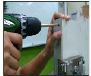
圖 51 安裝接合鋁片
