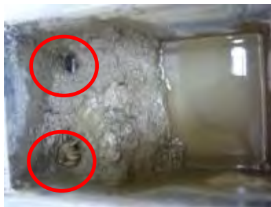
圖 56 永夜組第二天挖洞情形
