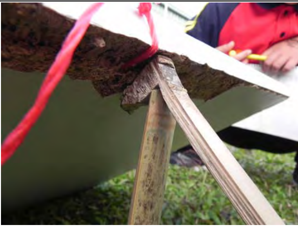
A 竹片撐住 B 竹片的竹節，木板壓住 B 竹片的竹節上端
