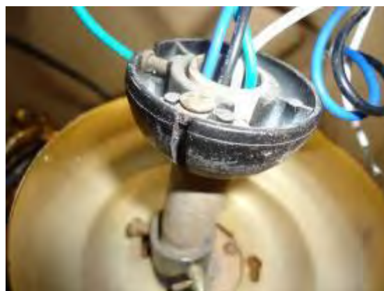
圖 59 吊扇吊桿上的球頭 (上方有凹槽)
