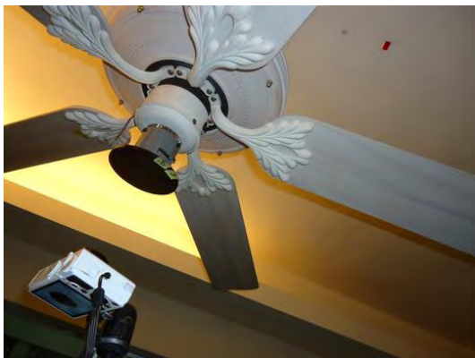
圖 49 全新吊扇安裝
