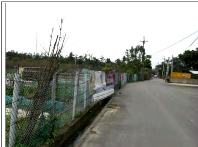
圖一福山巖清水祖師廟左前方人工灌溉渠道
