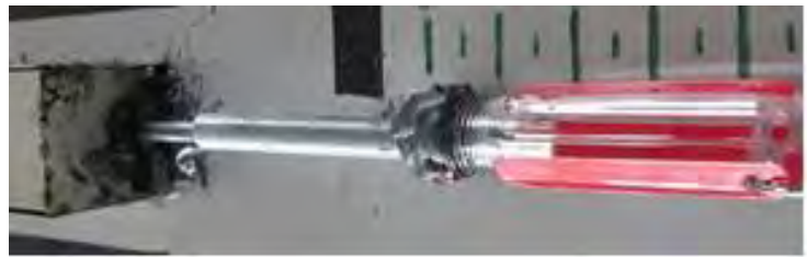
圖 5：塑鋼膠脫落情況
