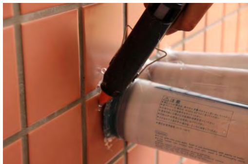
圖十一 用熱熔膠黏油墨罐在牆上
