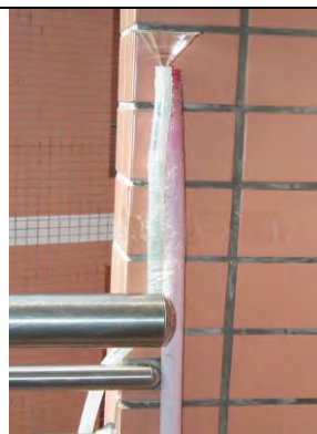
圖二十二 四樓走廊水管最上端
