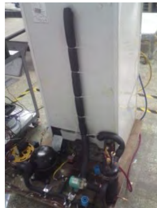
圖 4.29 設備改裝完成
