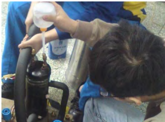
圖 4.26 將儲熱水桶內 加入 1400 c.c.的不凍液
