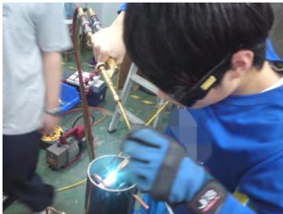
圖 4.16 將儲熱桶內的銅管銲起來示意圖
