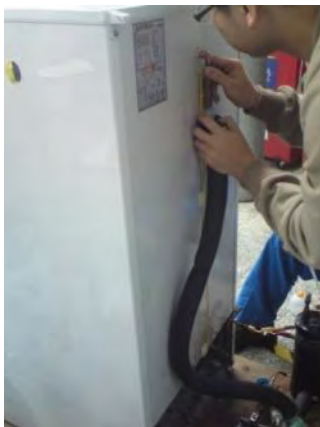
圖 4.28 將水管保溫，使用束線帶綁緊
