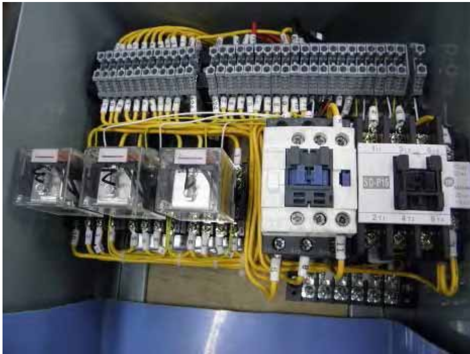
圖十 控制線路安裝
