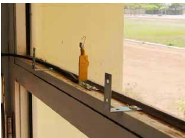
圖 7-1 將同軸電纜固定到教室的窗戶上
